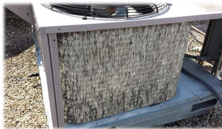
Damaged Fins
